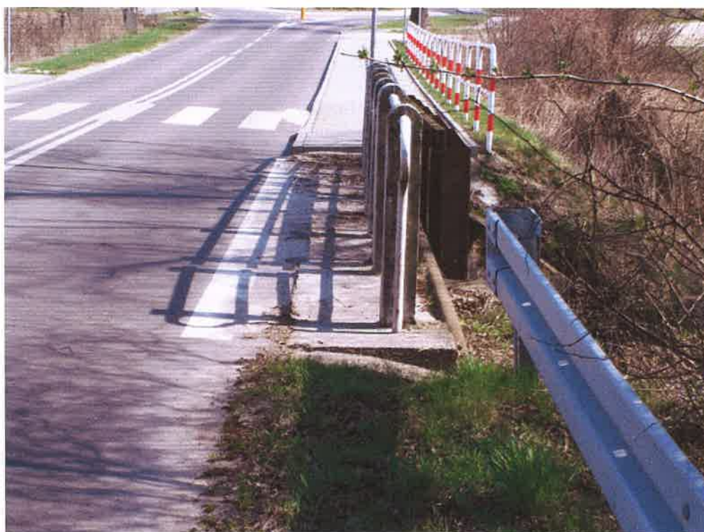
Fot. 13. Prowadnica bariery nie zlicowana z balustradą.
