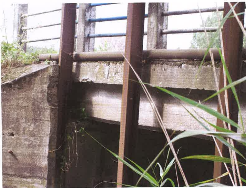
Fot. 5. Korozja prowadnic zastawki i rury ochronnej – urządzenie obce.
