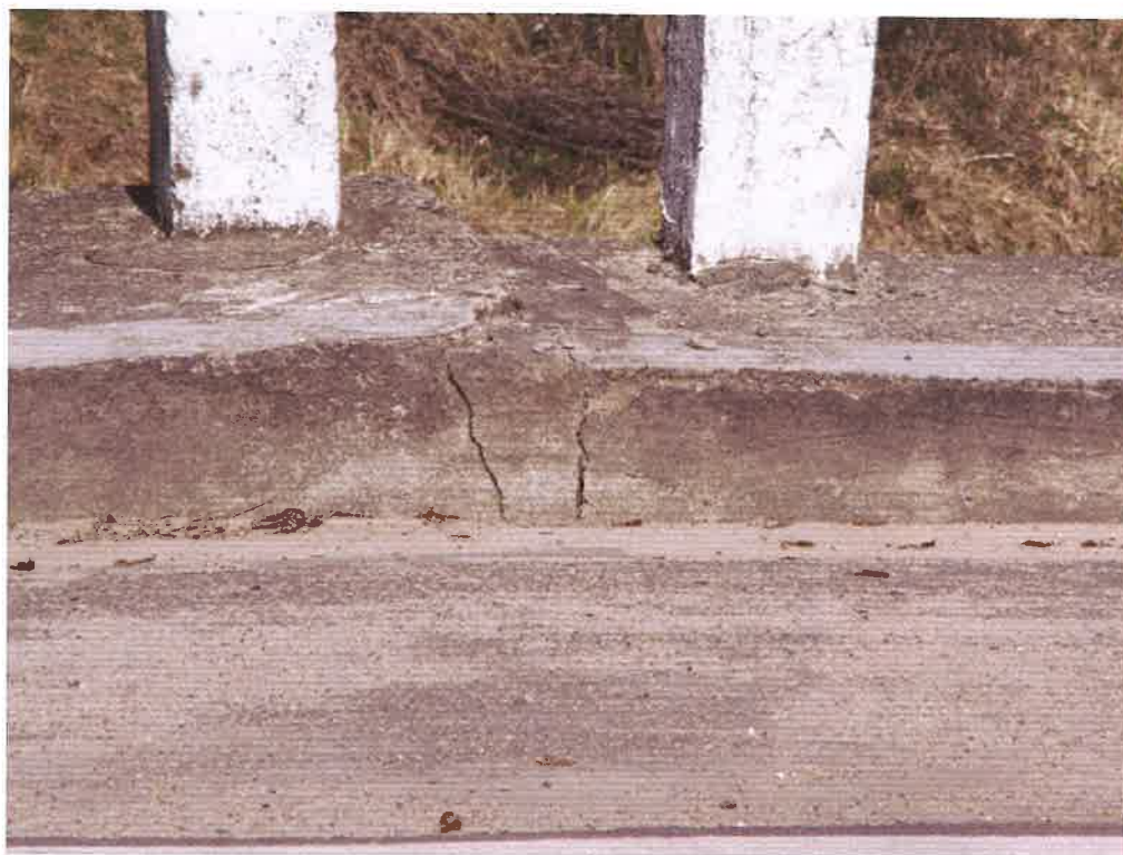
Fot. 15. Zarysowanie opaski w wyniku osiadania skrzydła.
