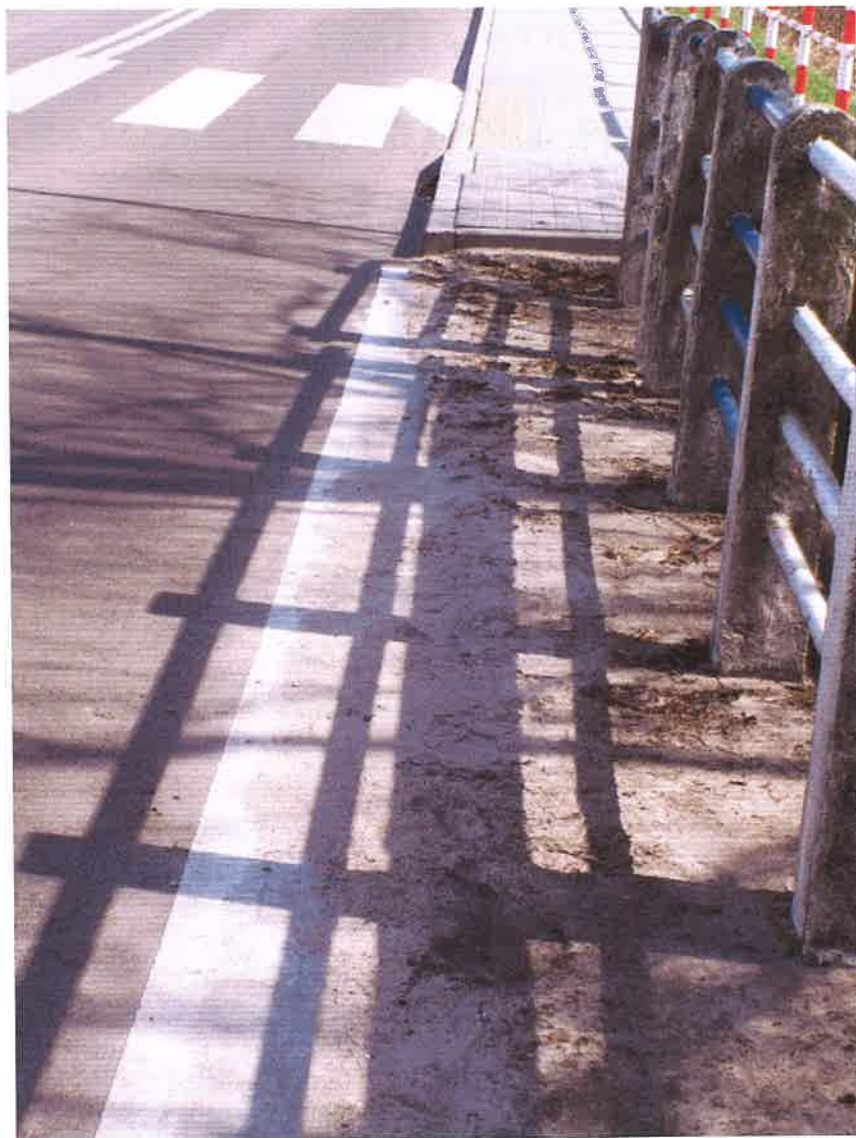
Fot. 21. Zanieczyszczenia na chodniku i porosty na słupkach balustrady.
