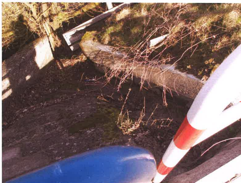
Fot. 17. Zniszczony i niedrożny ściek skarpowy
