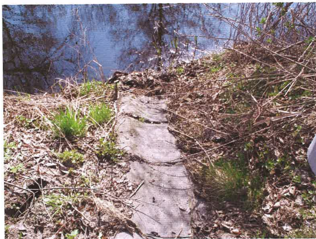
Fot. 12. Zanieczyszczony i uszkodzony ściek skarpowy.
