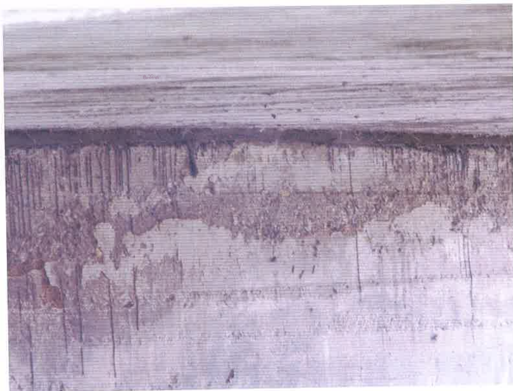
Fot. 7. Korozja betonu korpusu przyczółka w strefie podporowej.
