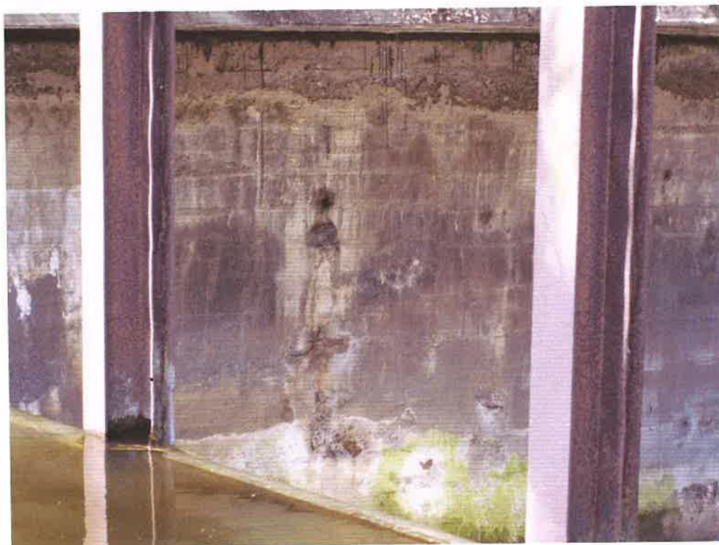
Fot. 6. Ubytki i korozja betonu przyczółka.
