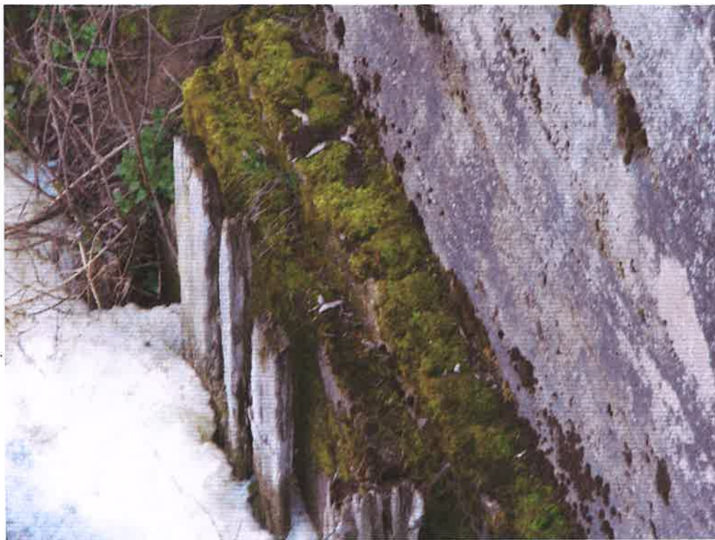
Fot. 19. Porosty na prawobrzeżnym skrzydle od strony dolnej wody oraz korodujące pozostałości drewnianej ścianki szczelnej.
