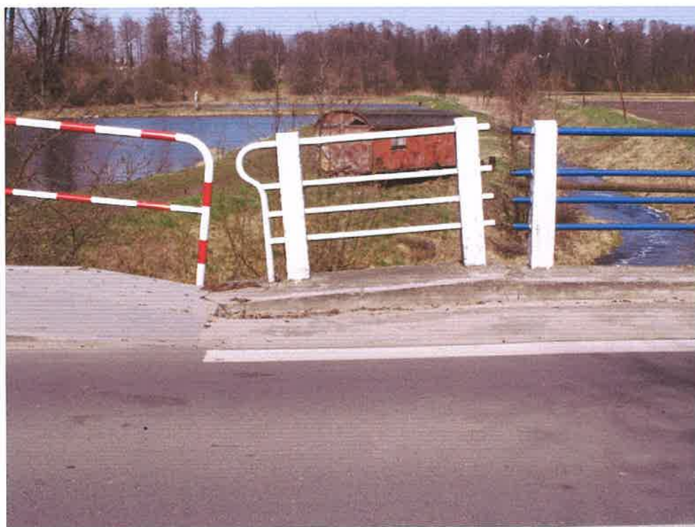
Fot. 14. Niweleta chodnika dopasowana do zapadniętego skrzydełka!??
