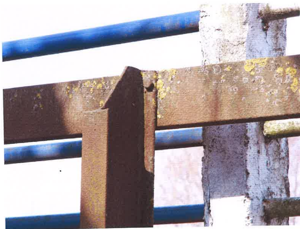
Fot. 10. Korozja stalowej konstrukcji zastawek – urządzenie obce.
