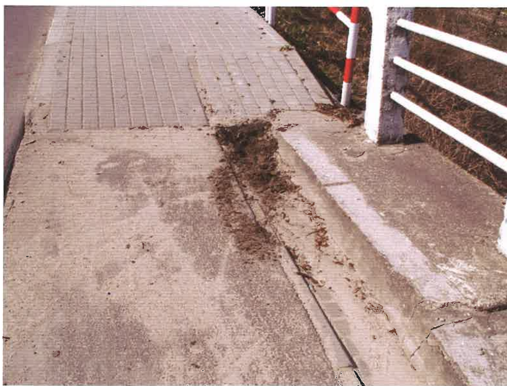
Fot. 16. Zasypany wlot odwodnienia.
