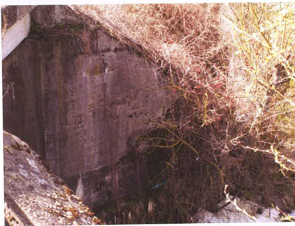
Fot. 9. Destrukcja lewobrzeżnego skrzydła od strony dolnej wody.
