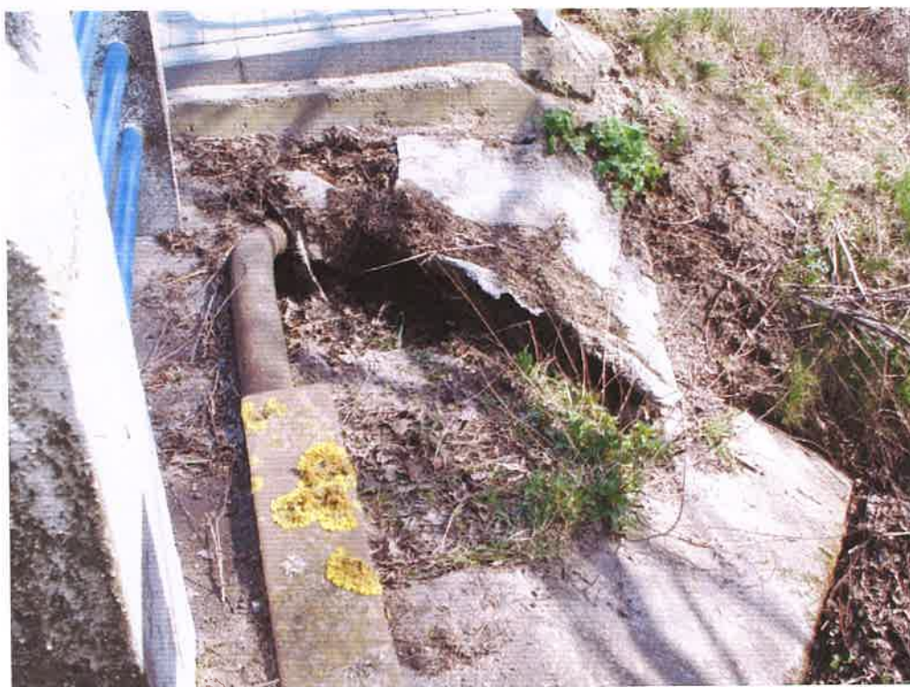
Fot. 11. Zniszczone umocnienie stożka.
