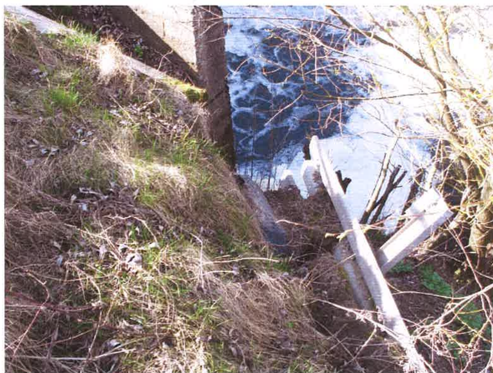
Fot. 18. Zniszczone prowizoryczne umocnienie skarpy.
