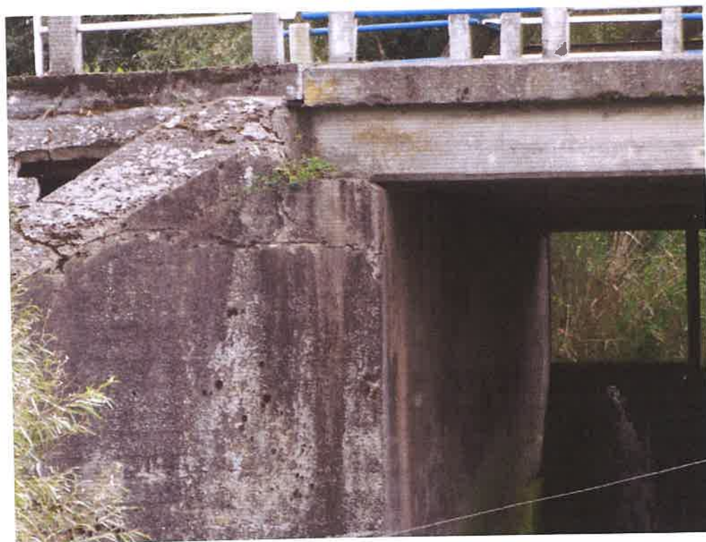
Fot. 8. Destrukcja prawobrzeżnego skrzydła od strony dolnej wody.
